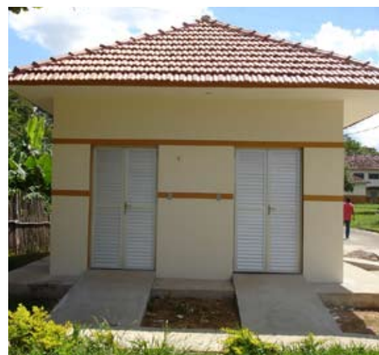
O abrigo de resíduos também ganhou novo espaço
