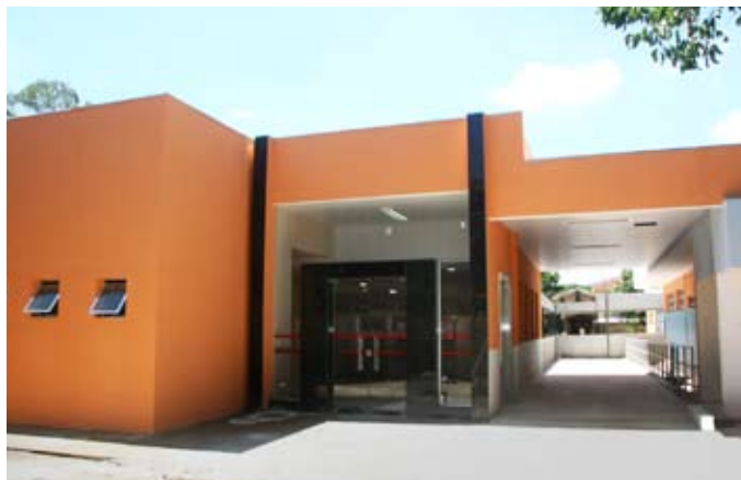
Nova entrada do Serviço de Urgência do Hospital Júlia Kubitschek
